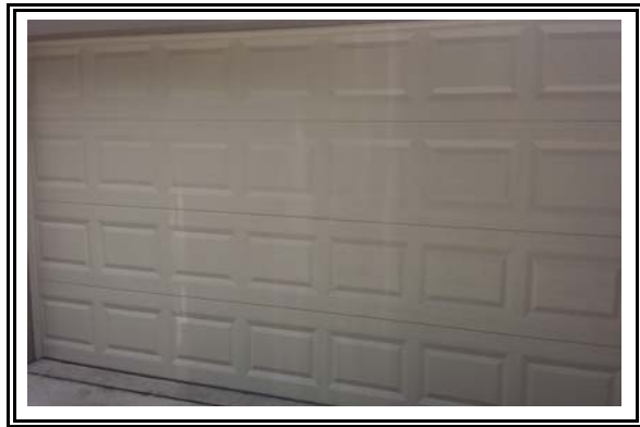
DOCUMENTATION PHOTO 1 GARAGE DOOR
